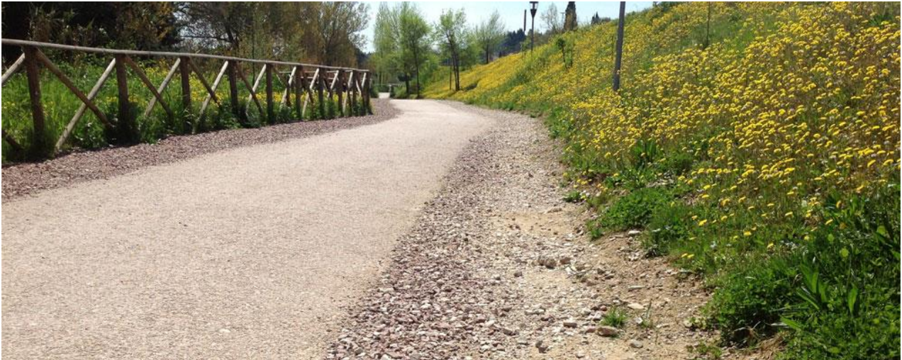
Esempio di pavimentazione in terra stabilizzata
