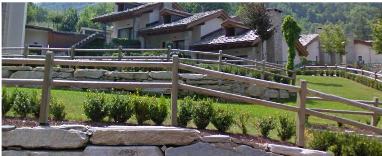
Recinzione recentemente installate nell'area a valle rispetto alla zona d'intervento
